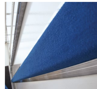
Seitliche Polsterlatte* für Möbeltransport (Höhe individuell festgelegt).
