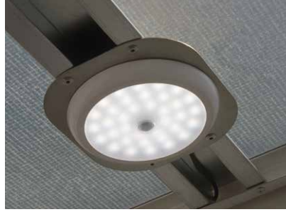
Sensorgesteuerte Decken-LED-Leuchte.
